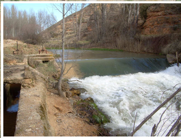
FOTO 8. Azud de Villel para riego, de 2,5m de altura y hormigón
